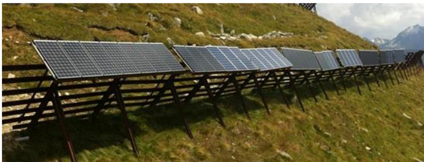
Abbildung 23: Beispielbild Photovoltaik auf Lawinverbauungen in Bellwald<sup>38</sup>
