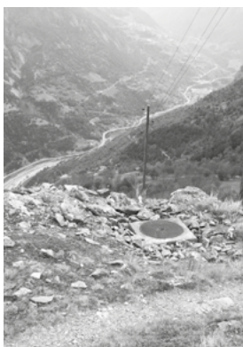
Ein Kontrollschacht – Hinweis auf die unterirdische Kanalisation
