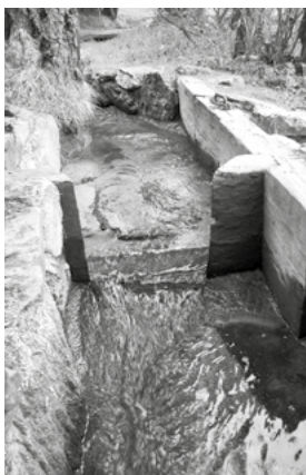
Suone mit Schieber, um das Wasser gerecht in die Verteilungskanäle zu leiten
