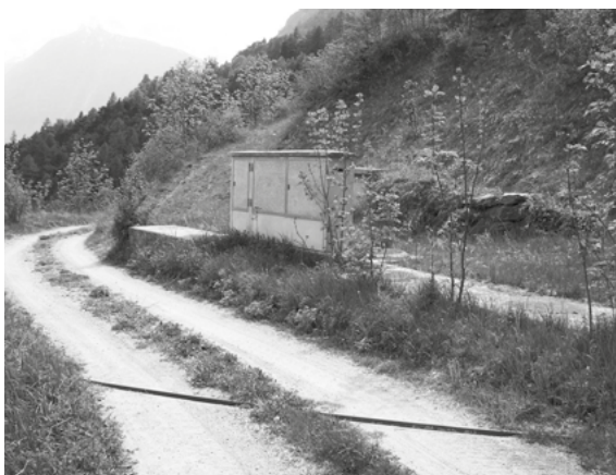
Unterirdisches Regenentlastungs-becken unterhalb Zeneggen
