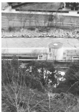
Die Kläranlage Stalden
