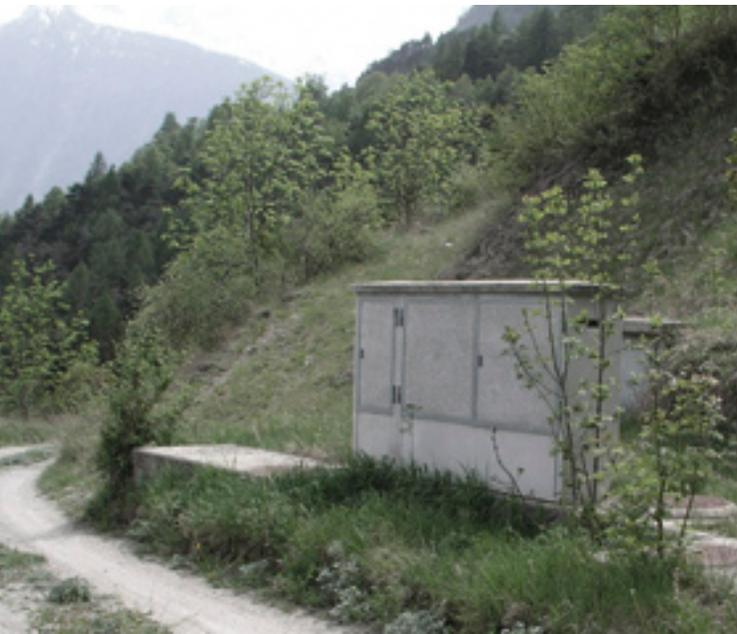
sinkt zu Boden. So findet bereits eine grobe Reinigung des Wasser statt. Sollte die Wassermenge für das Becken zu gross werden, kann via Überlauf fast sauberes Wasser in einen nahegelegenen Bach eingeleitet werden.
